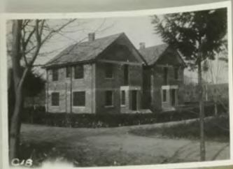
Narb House SE SW
