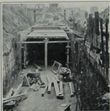
Des Moines Storm Sewers Construction 1933-1934
